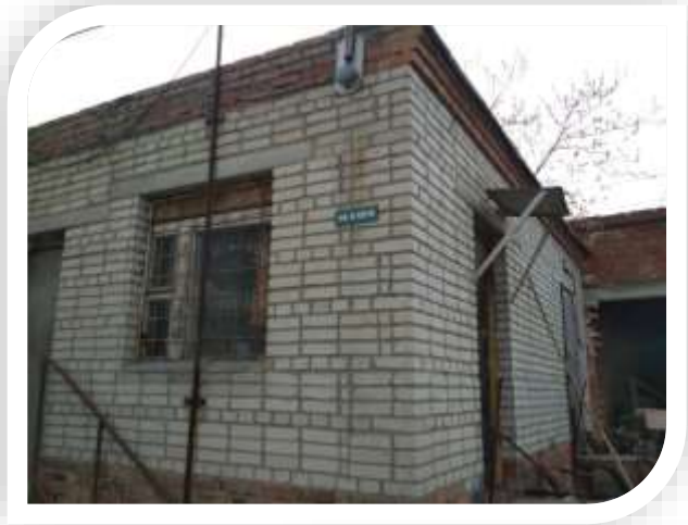
Здание проходной АТХ
